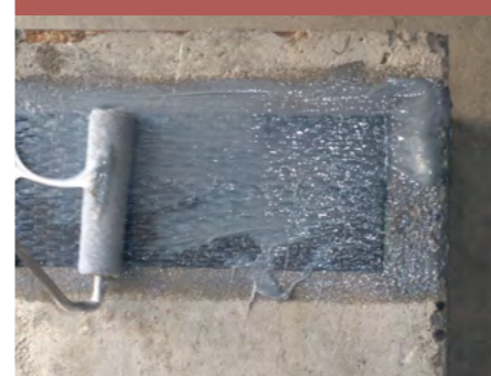
3. APPLICAZIONE 2° STATO RESINA
